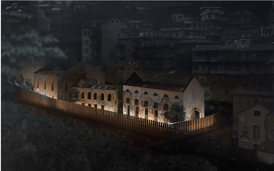
Vista del complesso dell'ex mattatoio illuminata dall'esterno
